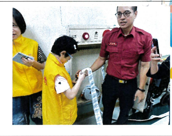
說明：檢查消防栓內部器材。
